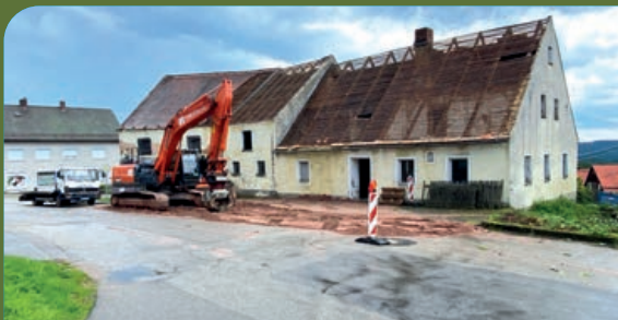
Die Abbrucharbeiten des „Jacklhauses“ zum Umbau einer Tagespflegeeinrichtung haben begonnen.
