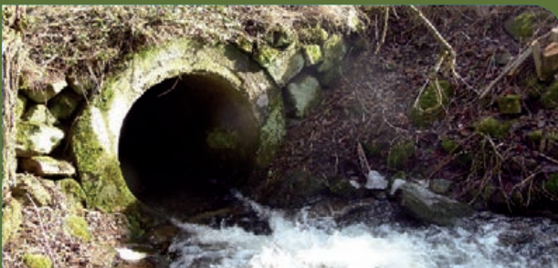
Verrohrte Überfahrt beim Kainzbach
