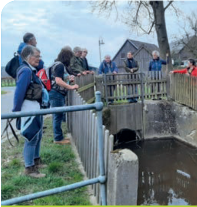
Komplett ausgebauter Abschnitt in Kleinschwand mit Aufstau zur Löschwasserbereithaltung
